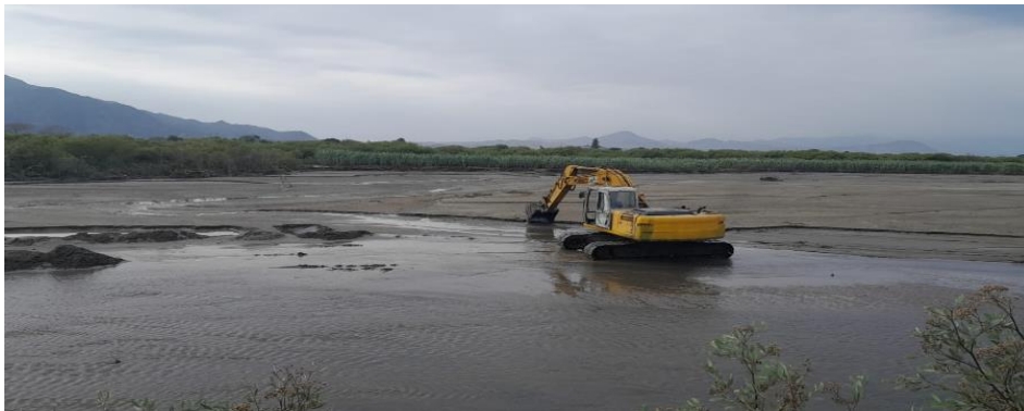
FIGURA N°01: Tramo crítico en el RÍO SAMANCO (RÍO NEPEÑA); en el sector de Cay Cay y Huambacho el Arenal , Distrito de Samanco, Provincia del Santa - Ancash. La meta física consta de la limpieza y descolmatación en el Tramo en mencion, conformación de dique con material propio en ambas márgenes y enrocado en la margen derecha y en la margen izquierda.
